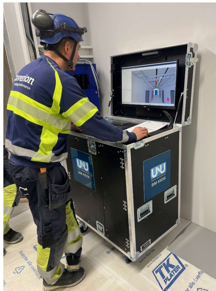
Figura 1 – Quiosque BIM em uso para a conferência de modelos BIM em obra. Crédito: Construtora UNU-AS, Noruega.
